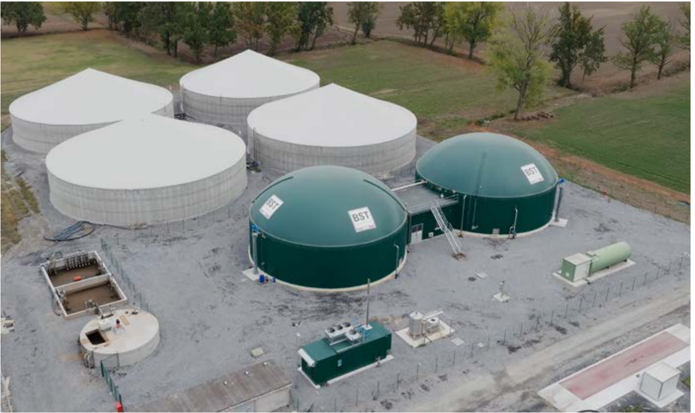
Dall'alto verso il basso: le quattro vasche dei liquami, i due digestori, la pompa che invia il biogas al motore, la struttura (verde) che ospita il motore/cogeneratore. La società agricola Tellina è situata in provincia di Parma, comune di Fontanellato, località Paroletta
