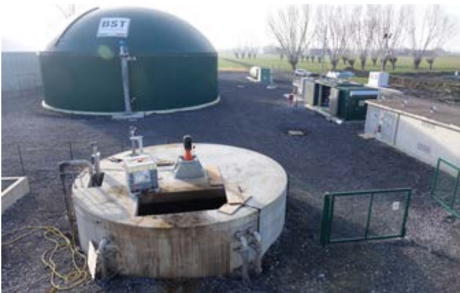
In alto, uno dei due digestori (il secondo è dietro). In basso, la vasca (cilindrica, in cemento) che raccoglie il digestato prima dell'invio di quest'ultimo al separatore
