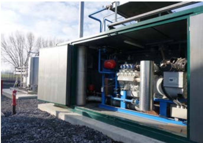
Qui accanto, due immagini del motore. Il motore è meglio definibile come cogeneratore dal momento che produce non solo energia elettrica ma anche energia termica
