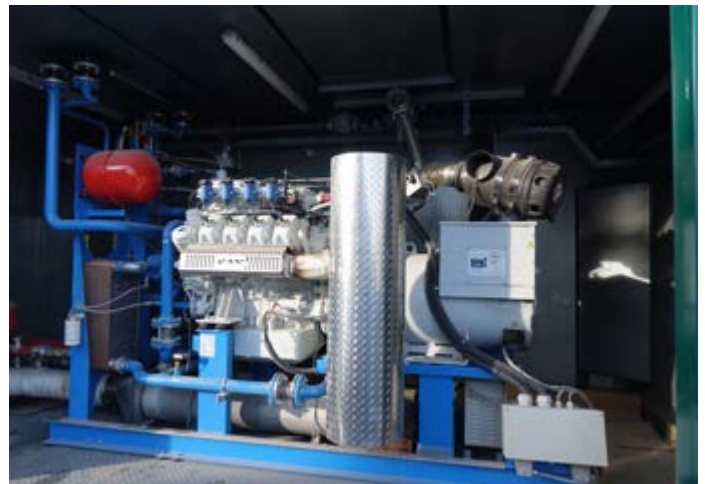
Qui accanto, due immagini del motore. Il motore è meglio definibile come cogeneratore dal momento che produce non solo energia elettrica ma anche energia termica
