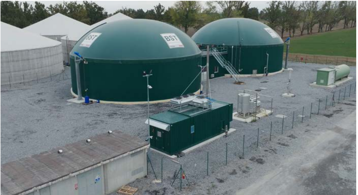
Un'altra veduta d'insieme dell'impianto biogas della società agricola Tellina. In alto a sinistra, le vasche di stoccaggio (bianche). Al centro, i due digestori (verdi). Sotto al centro, la pompa che indirizza il biogas al motore; sotto a sinistra la struttura (verde) che contiene il motore
