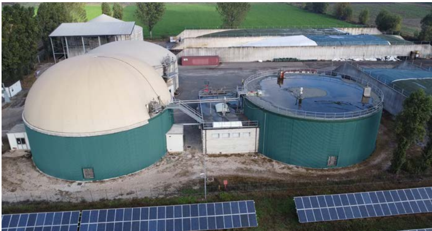
Una veduta dell'impianto biogas di Casalmoro. Martino Nodari è gestore, oltre che di questo, anche degli impianti biogas di Acquafredda (Bs) e di Asola (Mn). Da marzo 2023 i tre impianti sono di proprietà di Bioenerys spa, del Gruppo Snam
