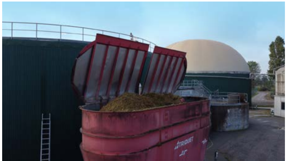
Il digestato risultante dall'azione dei tre impianti biogas viene utilizzato come fertilizzante
