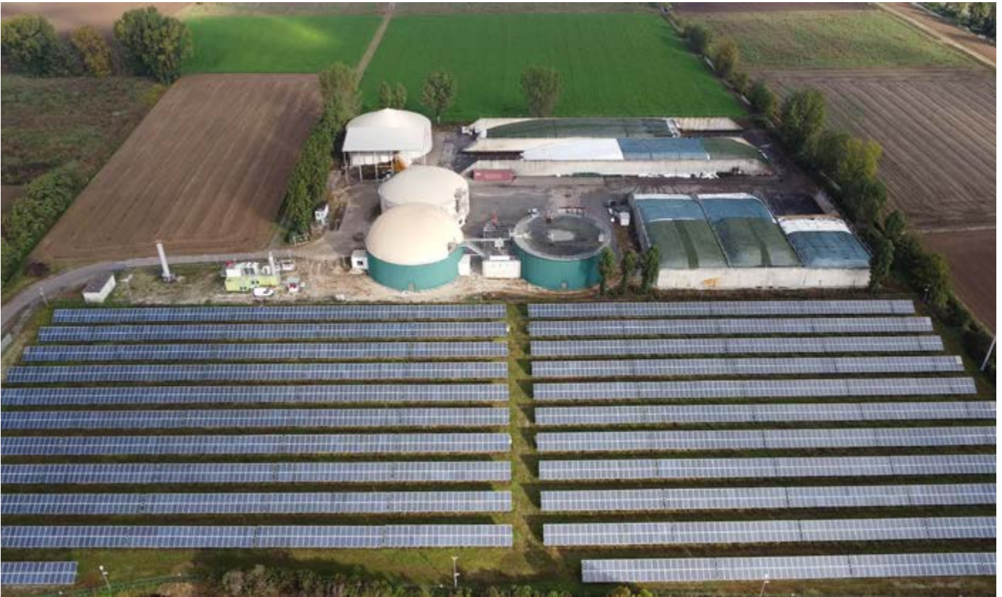
L'energia elettrica utilizzata dall'impianto biogas di Casalmoro è generata da un'imponente dotazione di pannelli fotovoltaici
