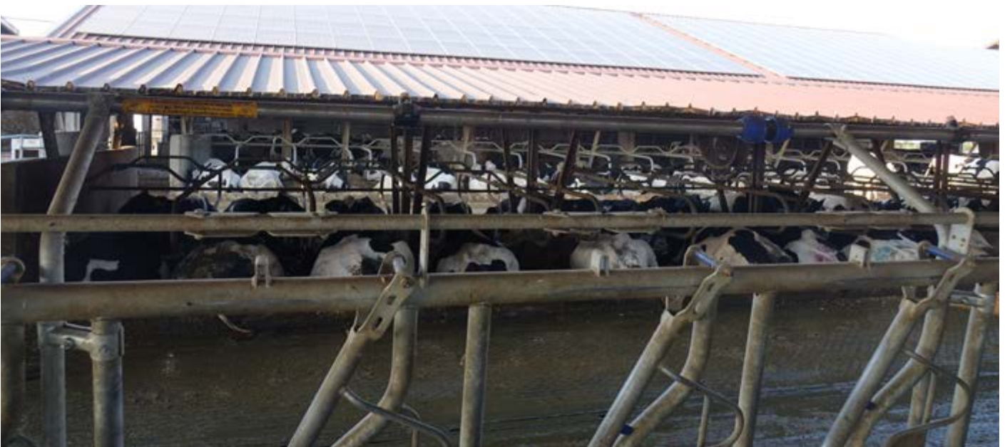
In alto: in evidenza i pannelli fotovoltaici, che producono 80 kWh in autoconsumo; l'energia elettrica così ottenuta è destinata soprattutto al frigo latte e ai ventilatori In basso: uno screenshot dello smartphone di Andrea Manclossi con l'indicazione di un elevato "indice di calore" per quattro delle proprie vacche
