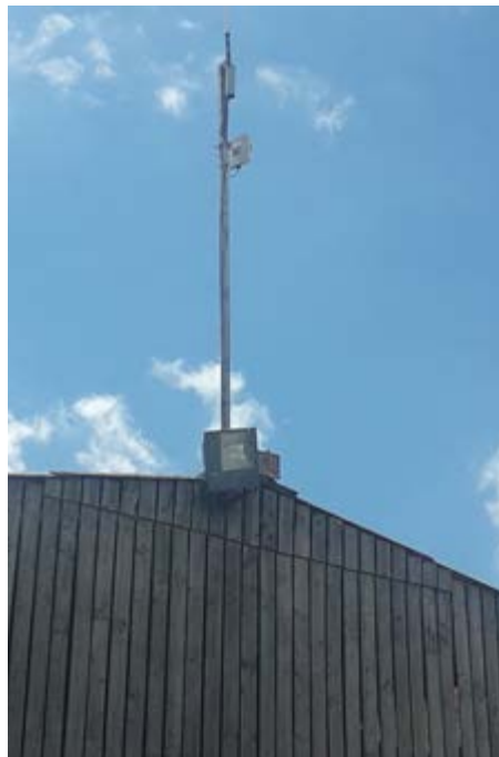
Nelle due foto, antenne posizionate in punti strategici dell'allevamento per fornire al carro Aura i riferimenti posizionali necessari per muoversi da solo
