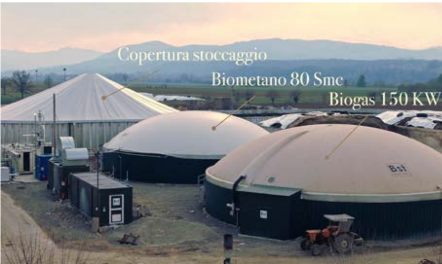
Accanto ai due impianti biogas si trova un grosso contenitore di stoccaggio digestato: Bst ne ha realizzato la copertura
