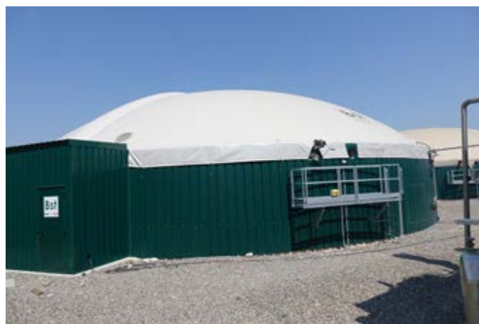
I due impianti biogas sono stati installati dalla Bst di Leno (Bs). Per maggiori informazioni sugli impianti: www.bst.srl ; info@bst.srl
