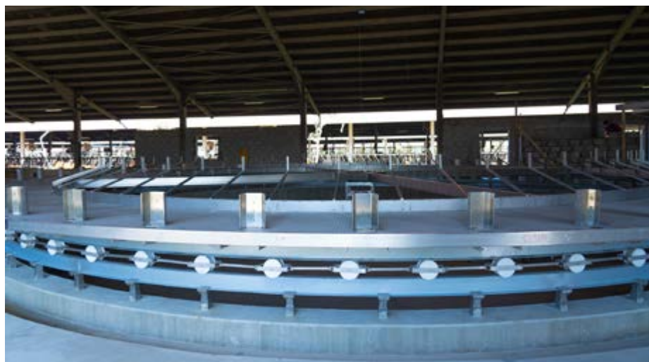
La grande sala di mungitura a giostra in via di allestimento.
