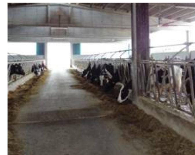
● Il passaggio tra la parte vecchia della stalla e la parte nuova. Evidente la differenza di luminosità tra i due locali.
