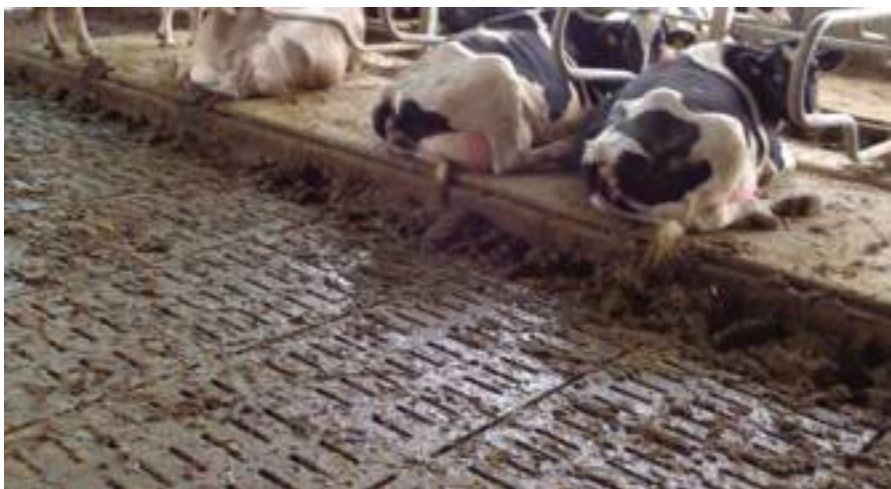
● Il grigliato trasversale assicura una buona presa e rapidità di asciugatura dei pavimenti. In quanto poi alle nuove cuccette, queste sono particolarmente apprezzate dagli animali, le occupano appena possibile.
