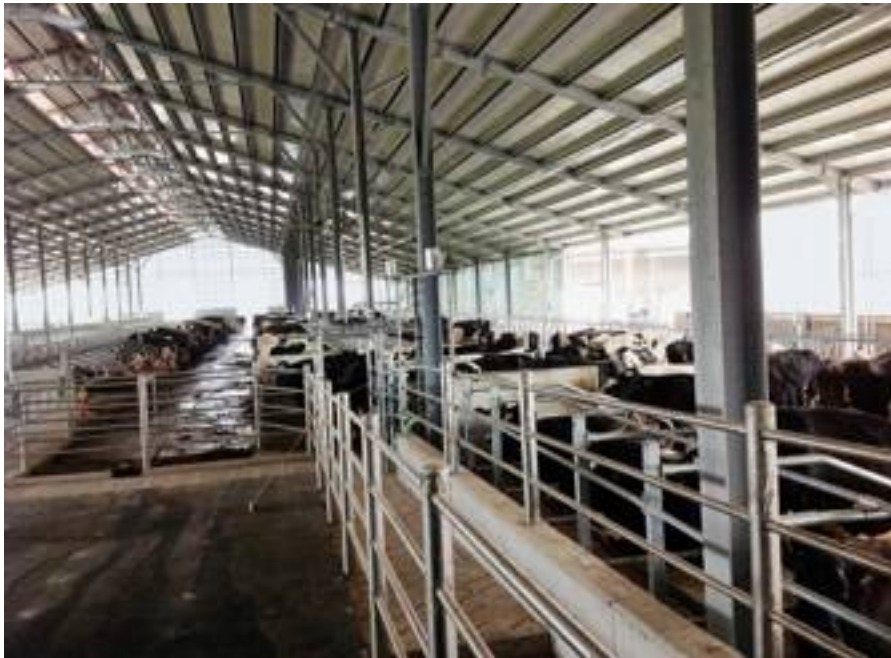
● Una ripresa interna della stalla. Si nota la presenza di un cupolino più largo del solito.
